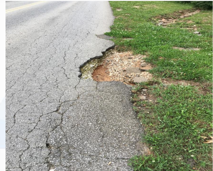
Edge Cracking
